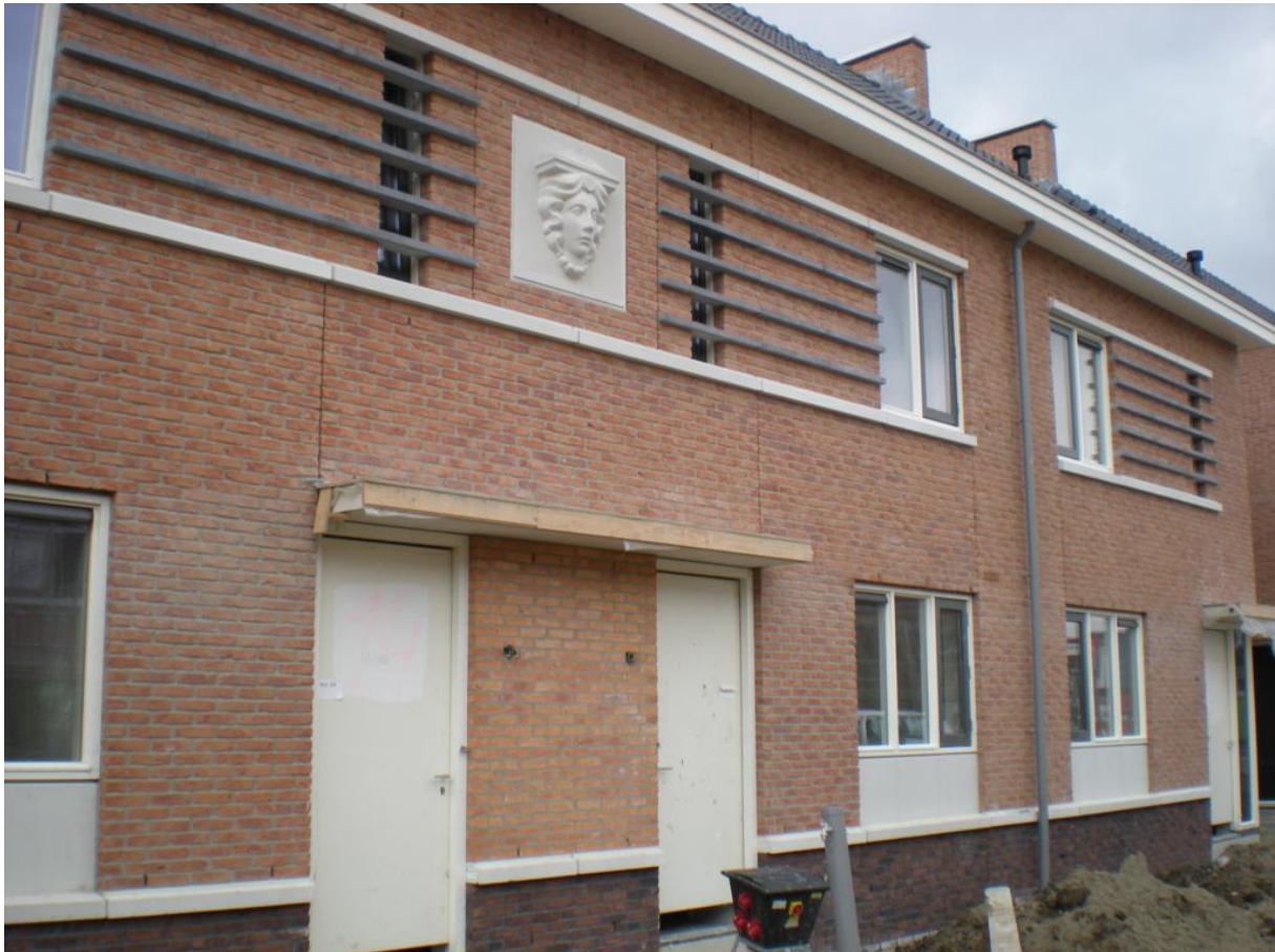
Afbeelding 44 Spekbanden als decoratief en als dragend onderdeel in de gevel
