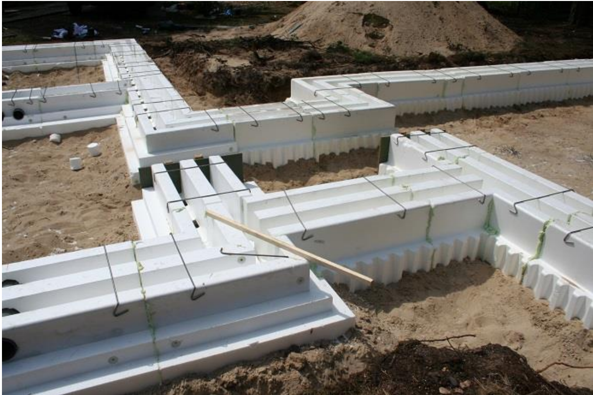
Afbeelding 15 Strokenfundering met PS-bekisting
