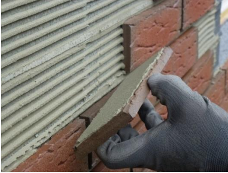
Afbeelding 49 Steenstrips aanbrengen
