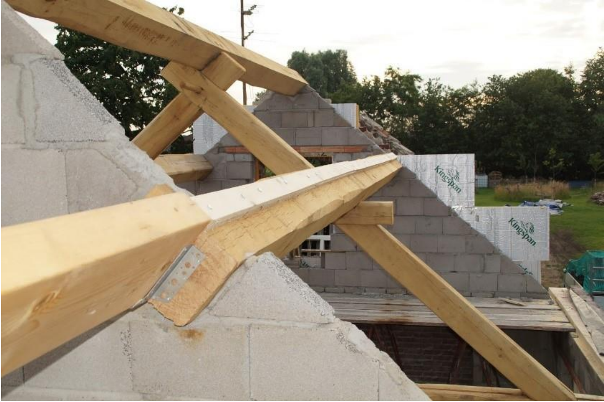
Afbeelding 16 Gordingen opgelegd op tussenmuur en topgevel
