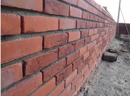
Afbeelding 4 Maatvoering, koppen en lagenmaat
