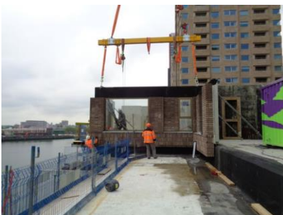
Afbeelding 51 Gemetseld gevelelement plaatsen
