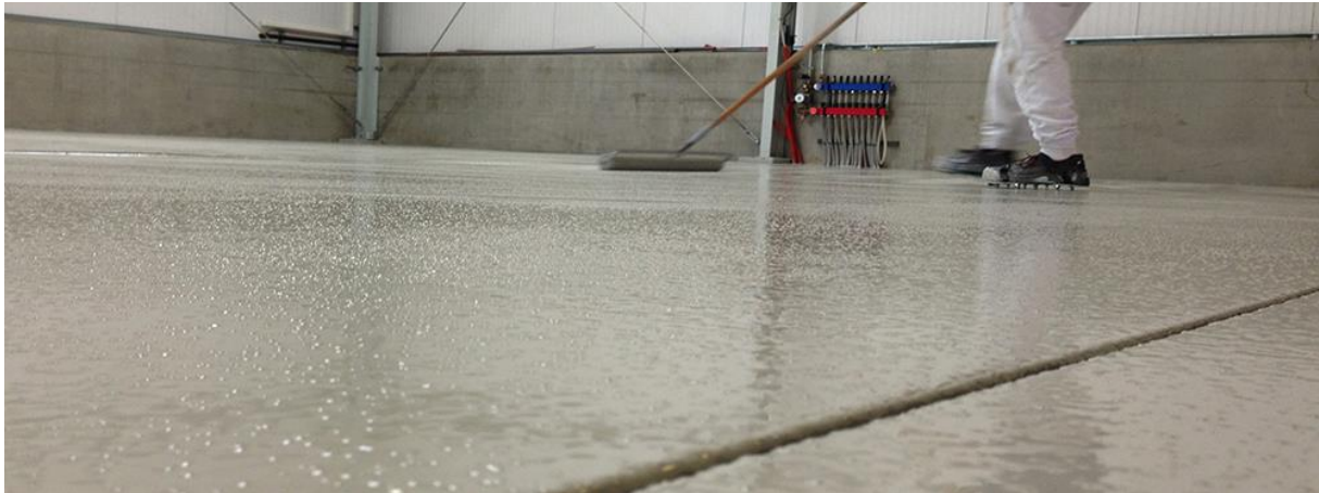
Afbeelding 4 Dilatatie in betonvloer
