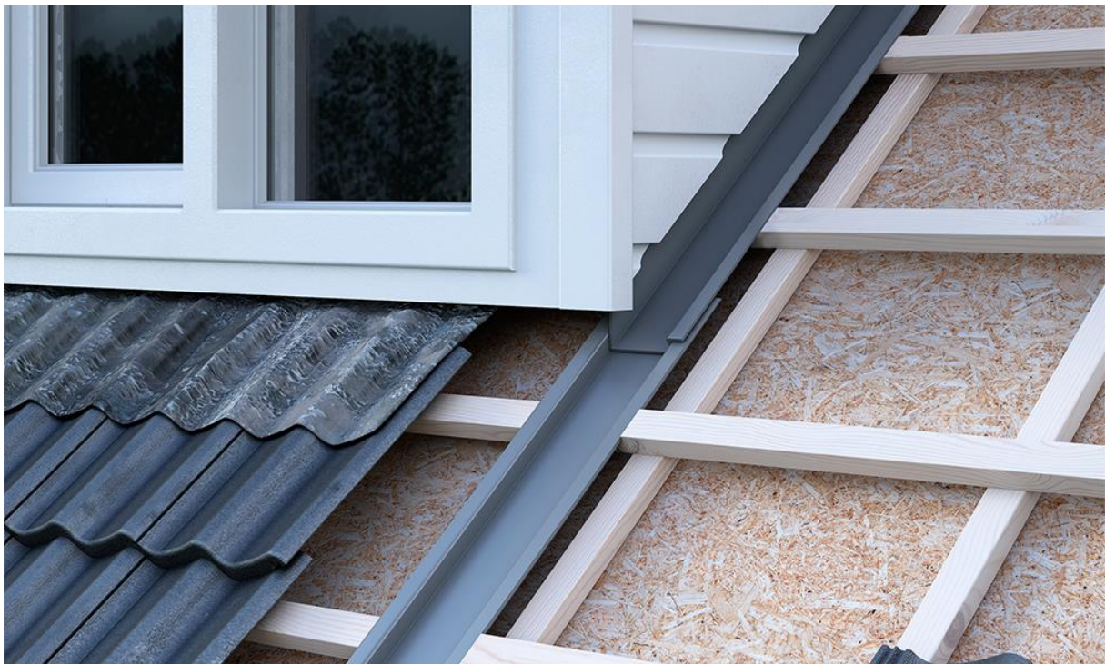
Afbeelding 34 Verholen gootdetails
