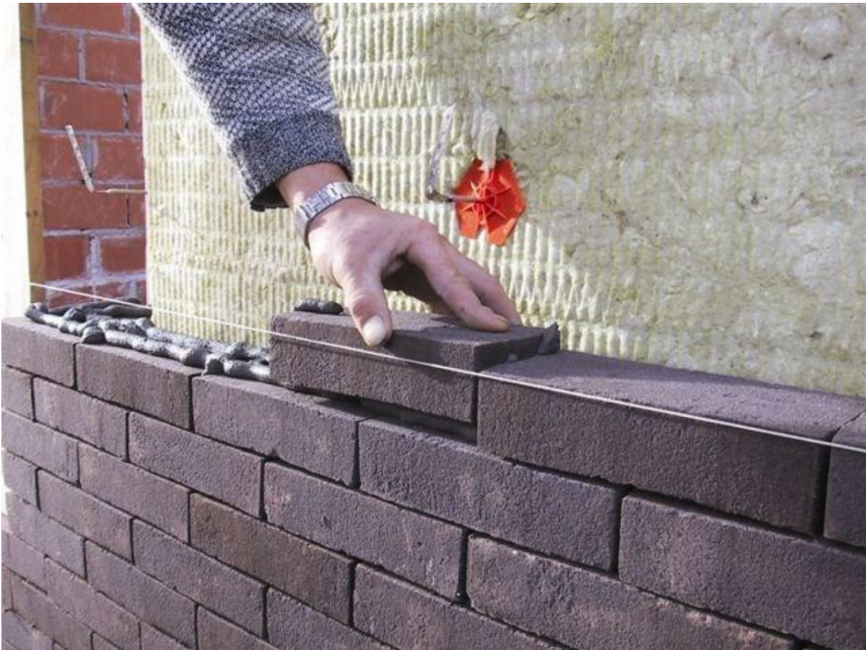
Afbeelding 47 Baksteen lijmen
