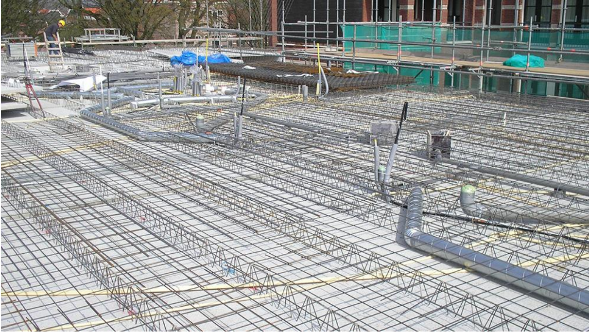
Afbeelding 12 Breedplaatvloer met leidingen
