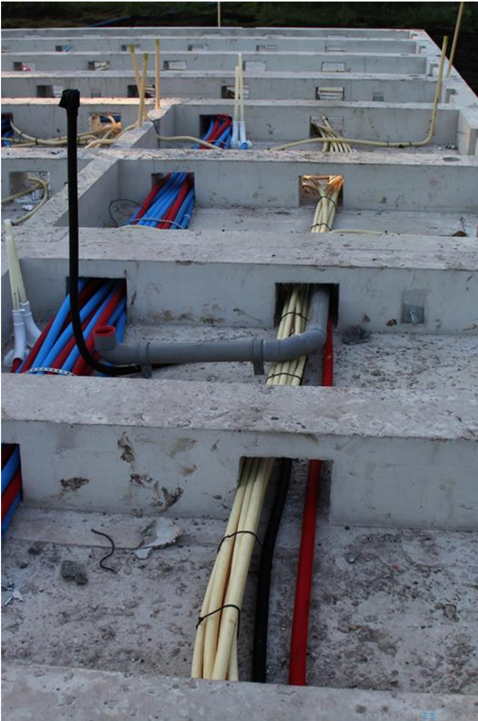
Afbeelding 5 Leidingen in betonvloer
