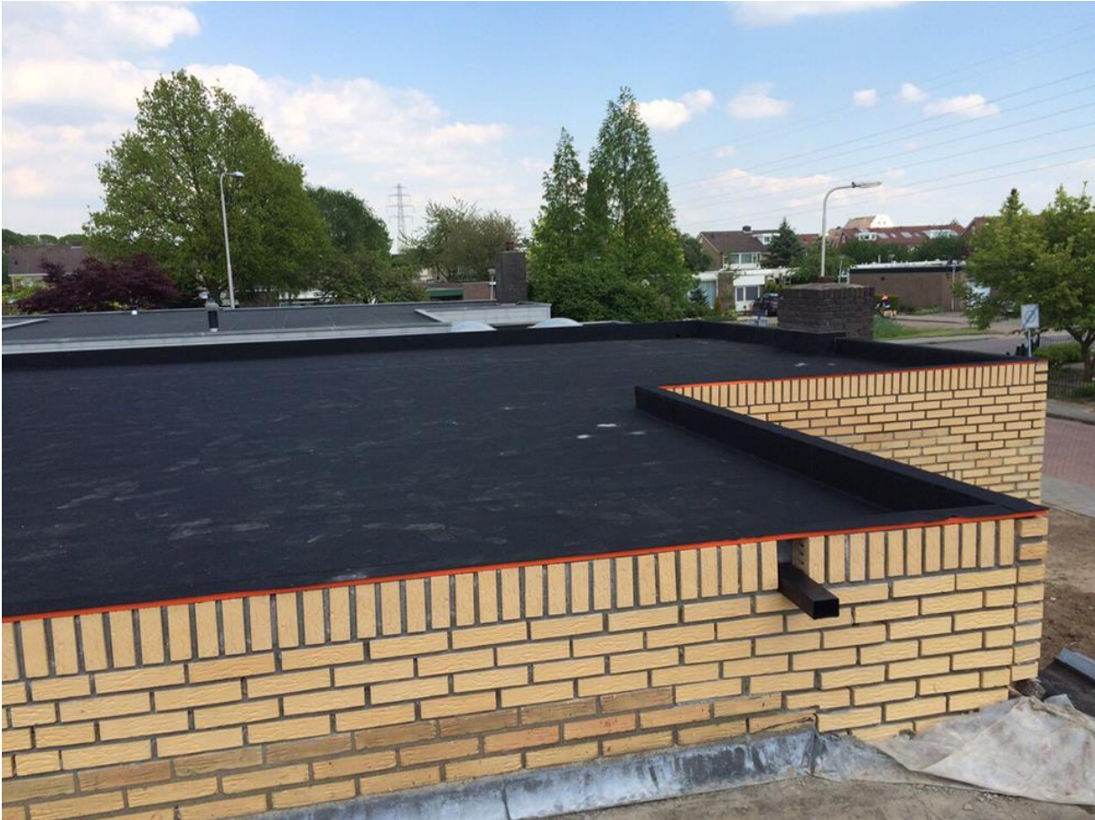
Afbeelding 2 Plat dak met opstand en stadsuitloop
