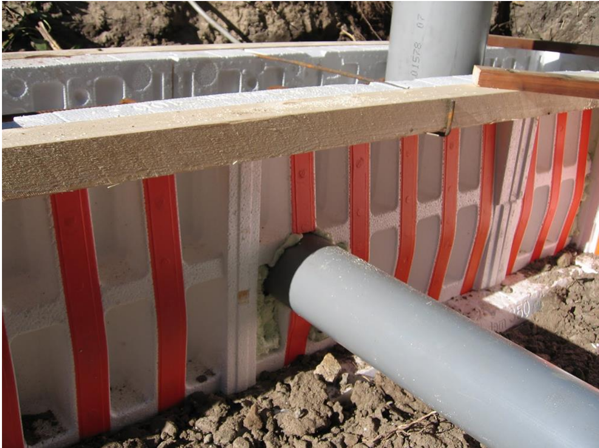
Afbeelding 14 PS-bekisting met afvoer
