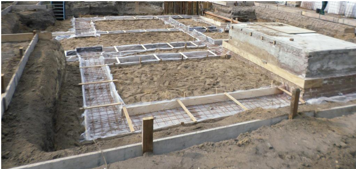
Afbeelding 14 Fundering op staal met houten bekisting
