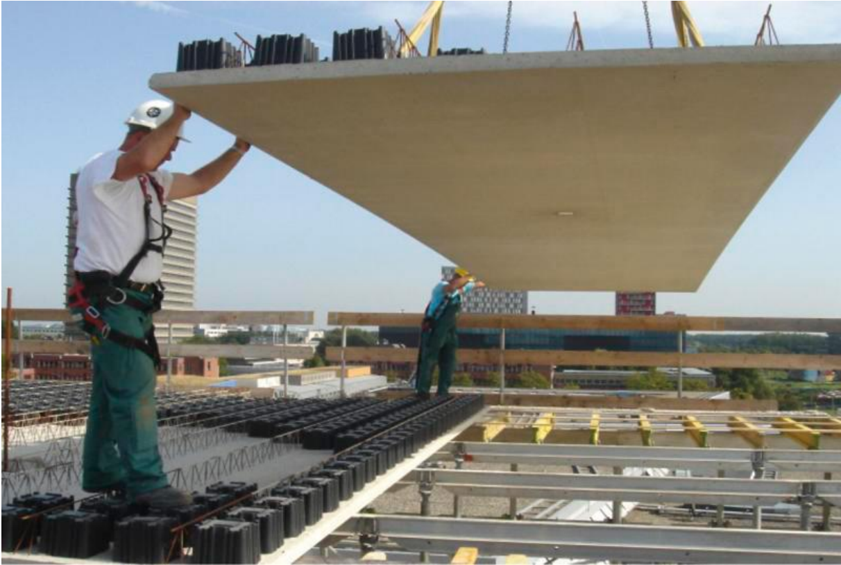
Afbeelding 13 Airdeckvloer plaatsen
