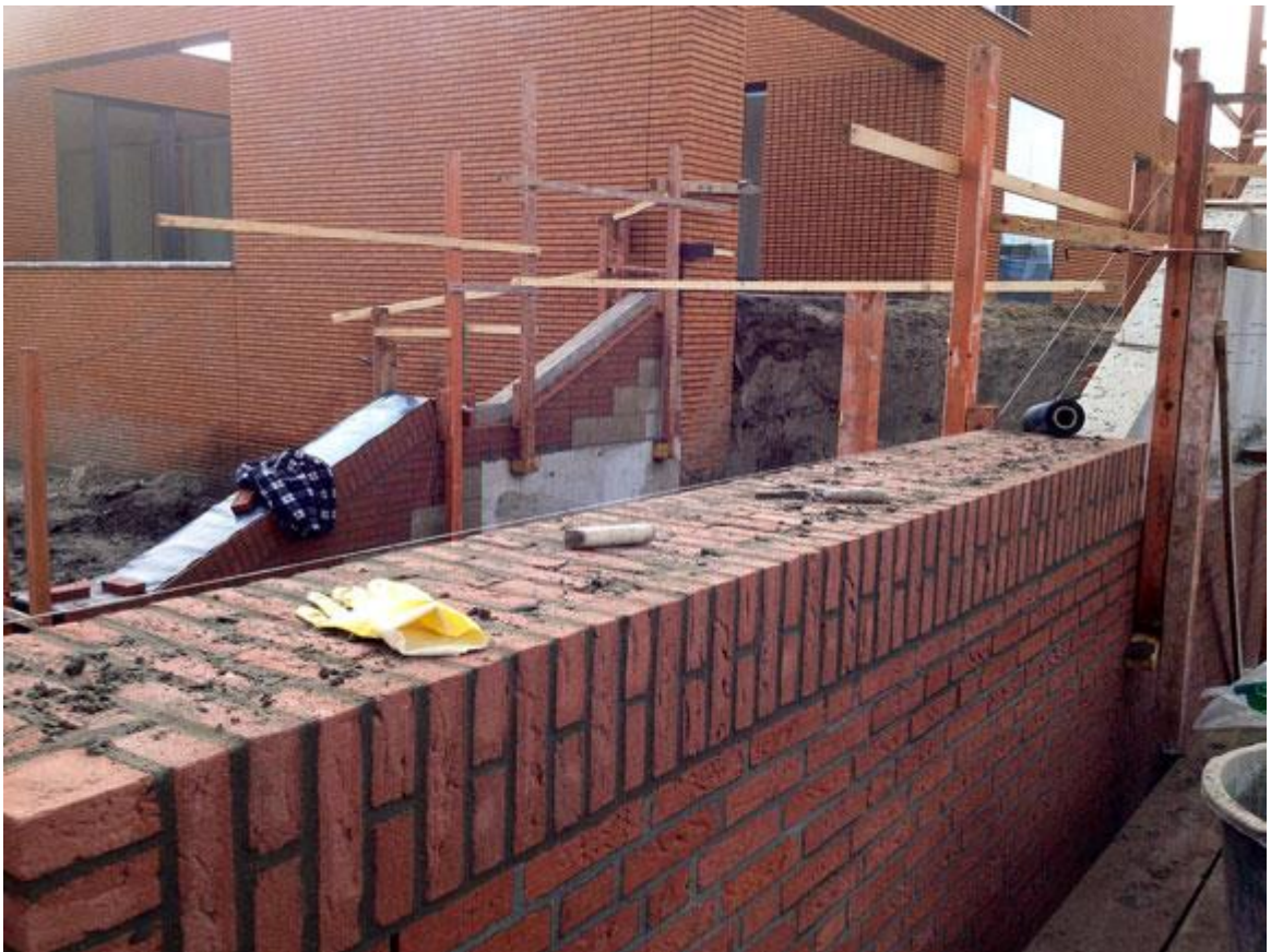
Afbeelding 40 Muurafdekking met rollaag
