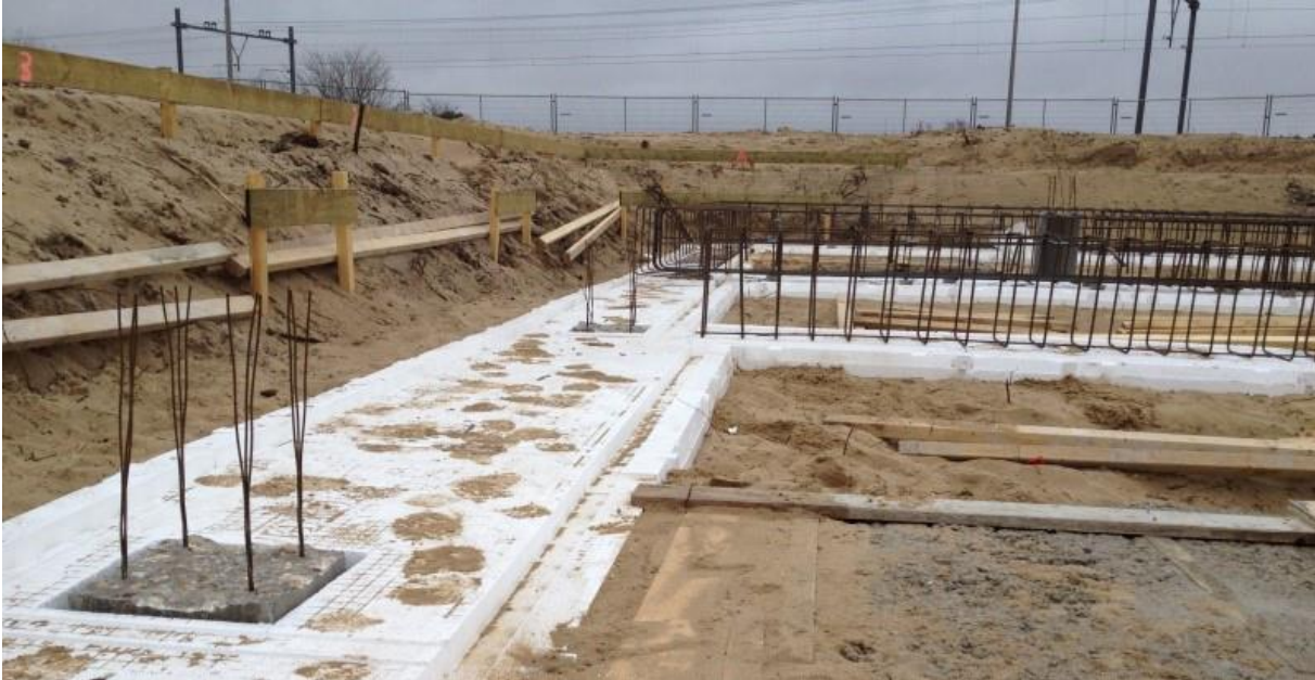
Afbeelding 12 Stekeinden van wapening heipalen in wapeningskorf van funderingsbalk
