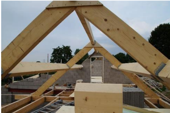
Afbeelding 18 Gordingen opgelegd: tussen de spanten en bevestigd met een gordinganker (links) en op het spant en bevestigd met een gordingklos (rechts)
