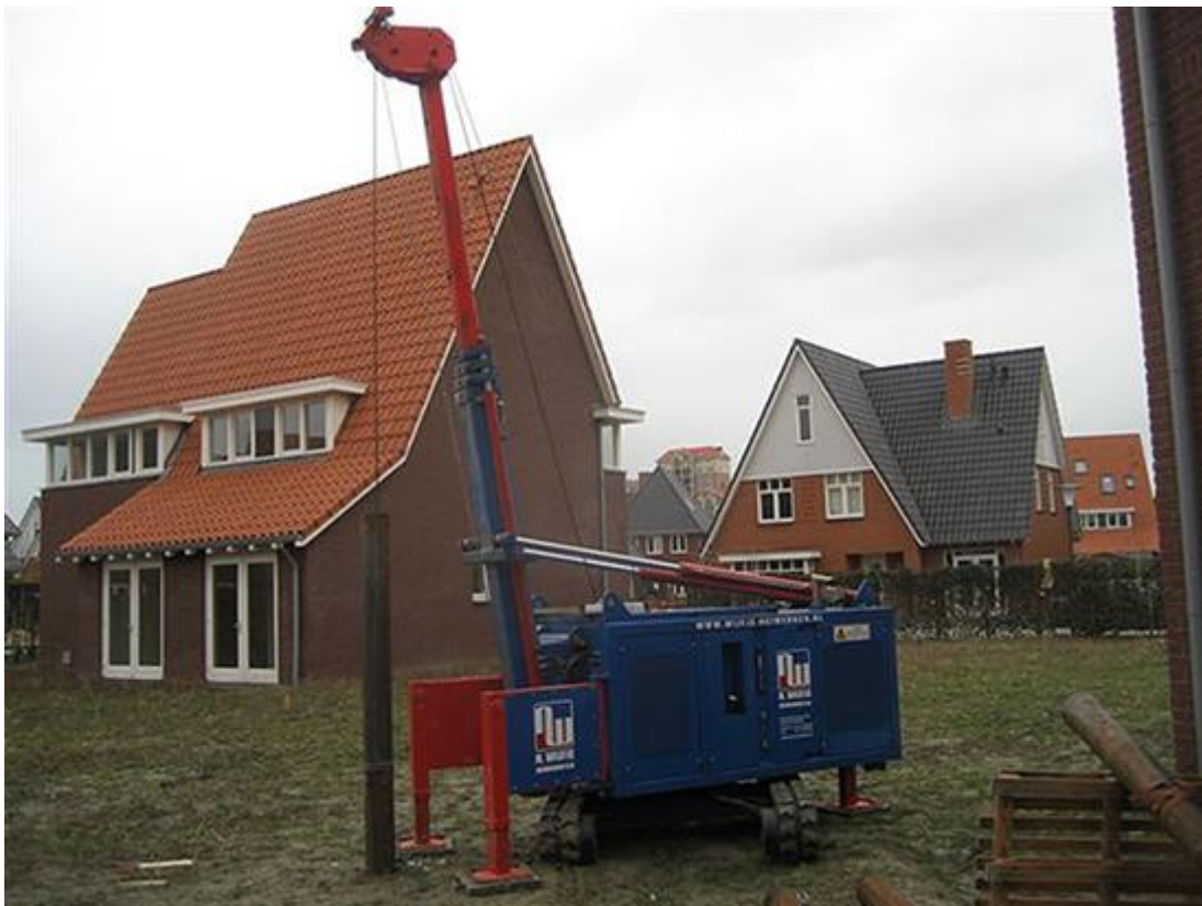
Afbeelding 4 Heistelling met stalen buispaal
