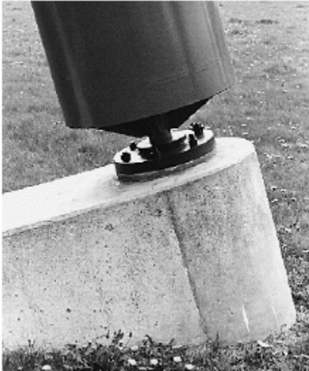
Afbeelding 9 Verankering van stalen kolomvoet op betonpoer
