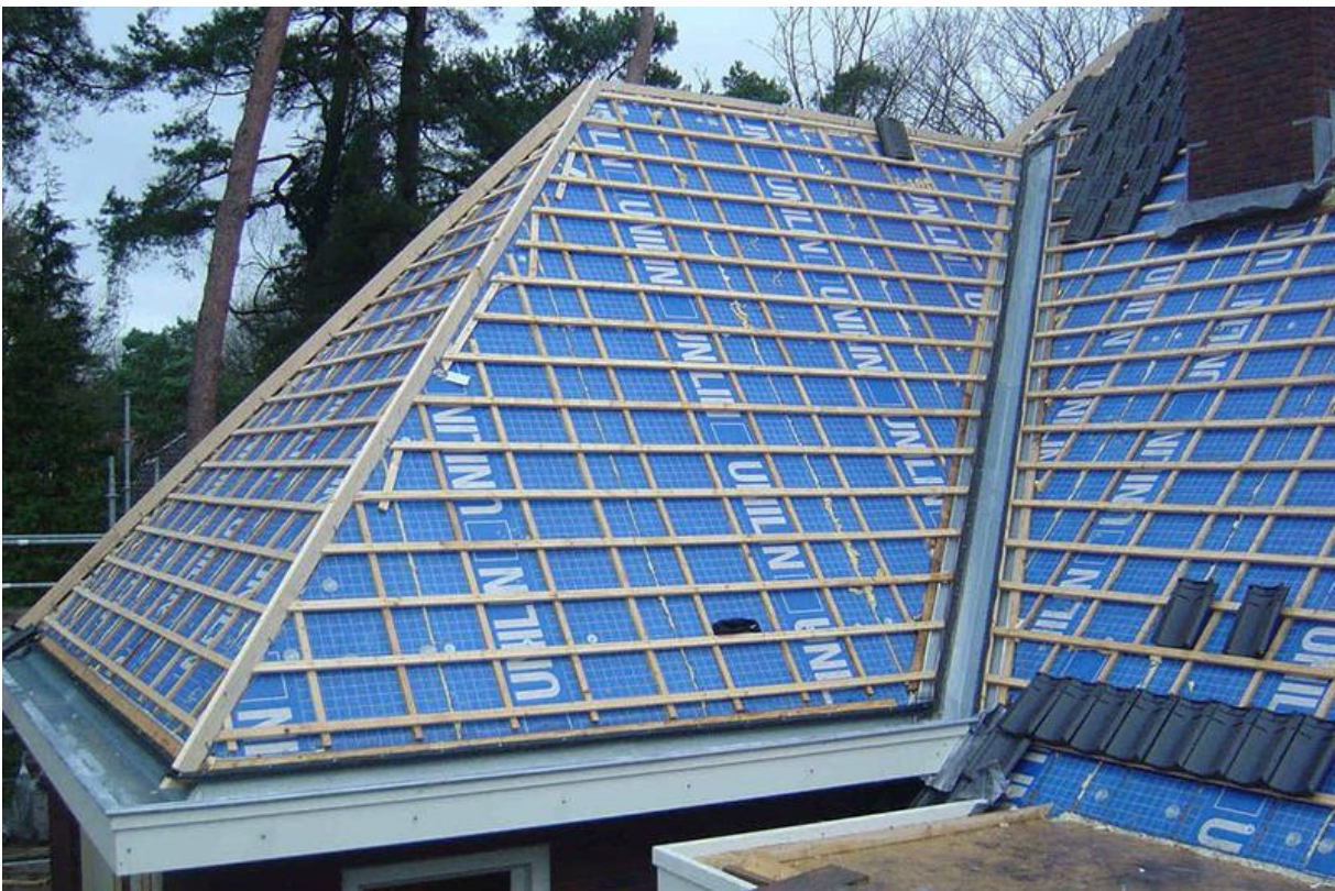
Afbeelding 47 Dak met hoekkeper, kilkeper en kilgoot
