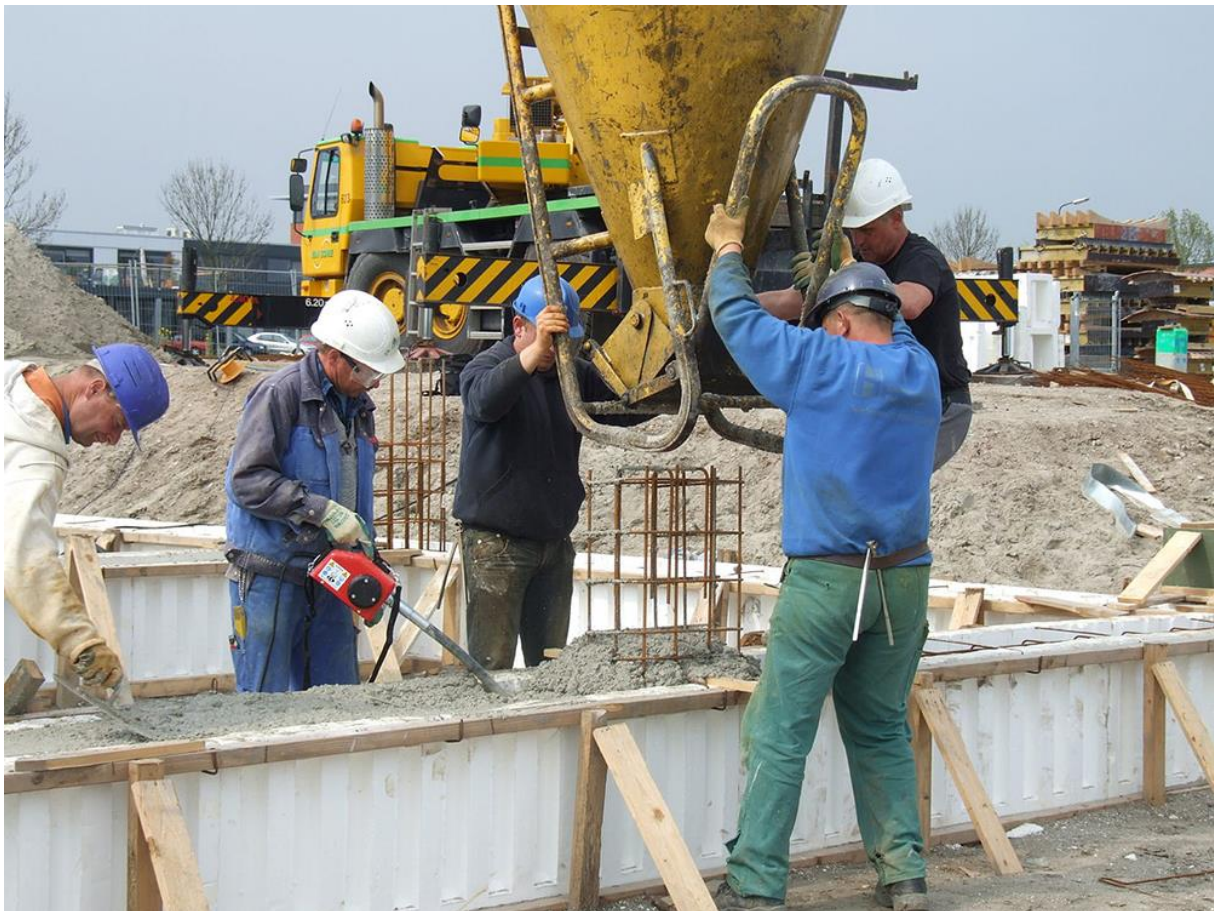
Afbeelding 16 Beton verdichten
