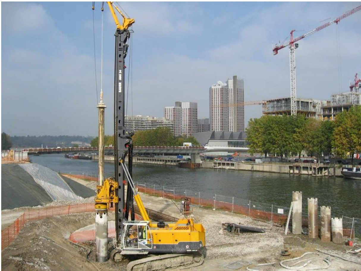
Afbeelding 3 Vibropalen aanbrengen
