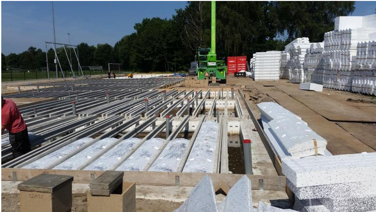
Afbeelding 7 PS-isolatievloer
