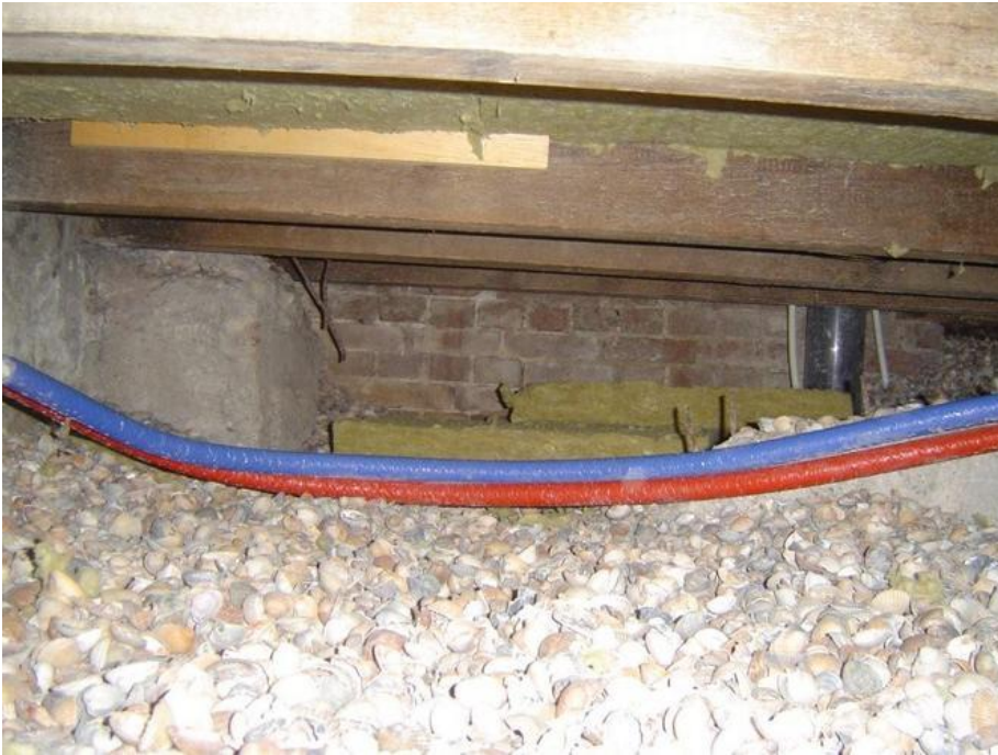
Afbeelding 20 Isolatie kruipruimte met schelpen
