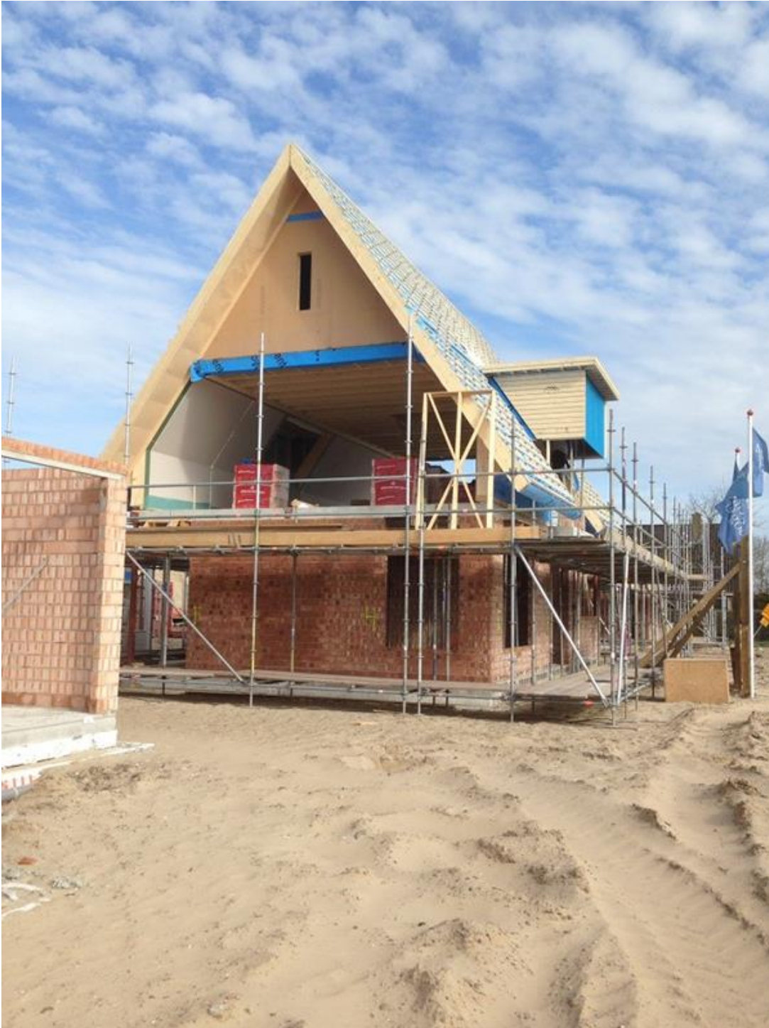
Afbeelding 2 Houten verdiepingvloer in nieuwbouw
