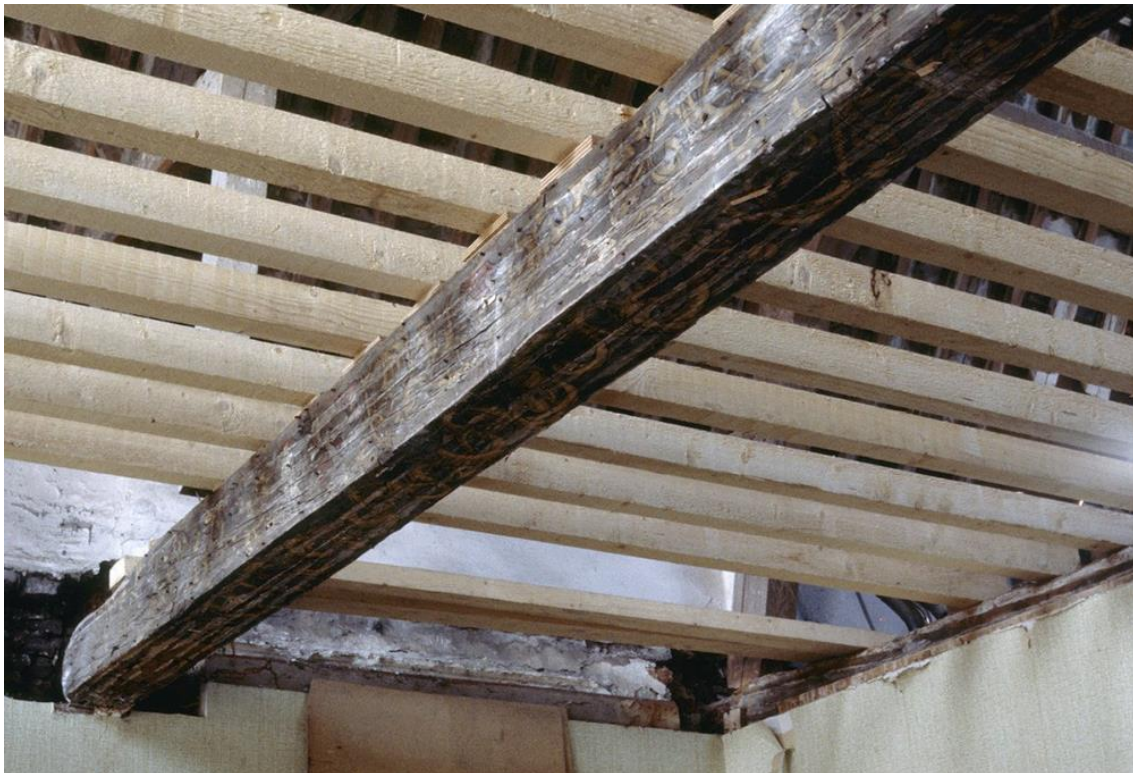
Afbeelding 18 Moerbalk onder vloerbalken
