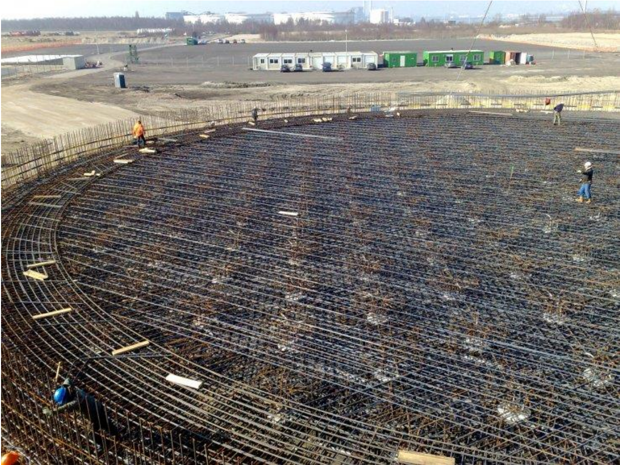
Afbeelding 3 Wapening betonvloer
