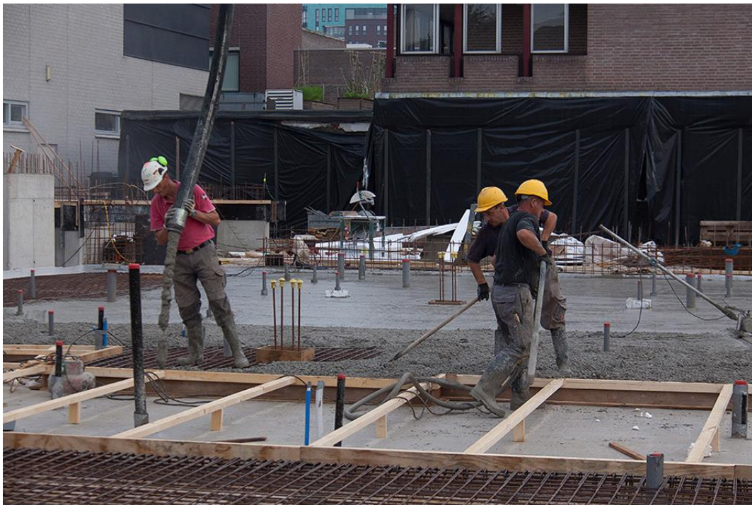
Afbeelding 6 Massieve plaatvloer storte
