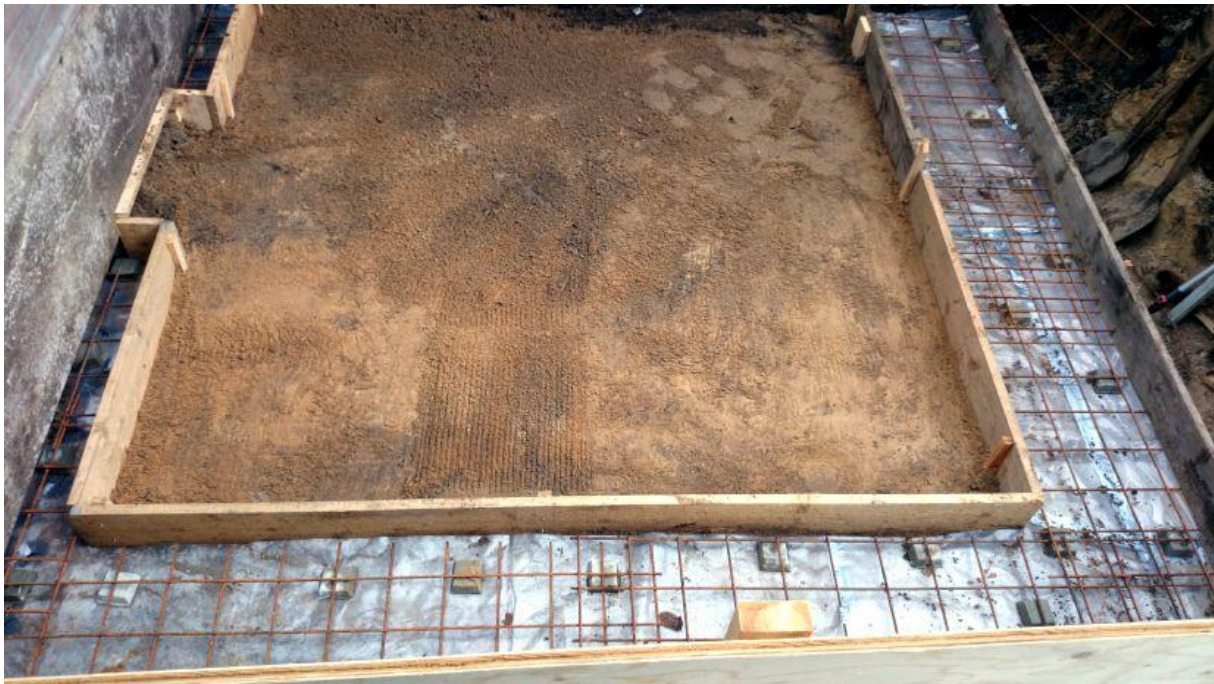
Afbeelding 11 Houten bekisting
