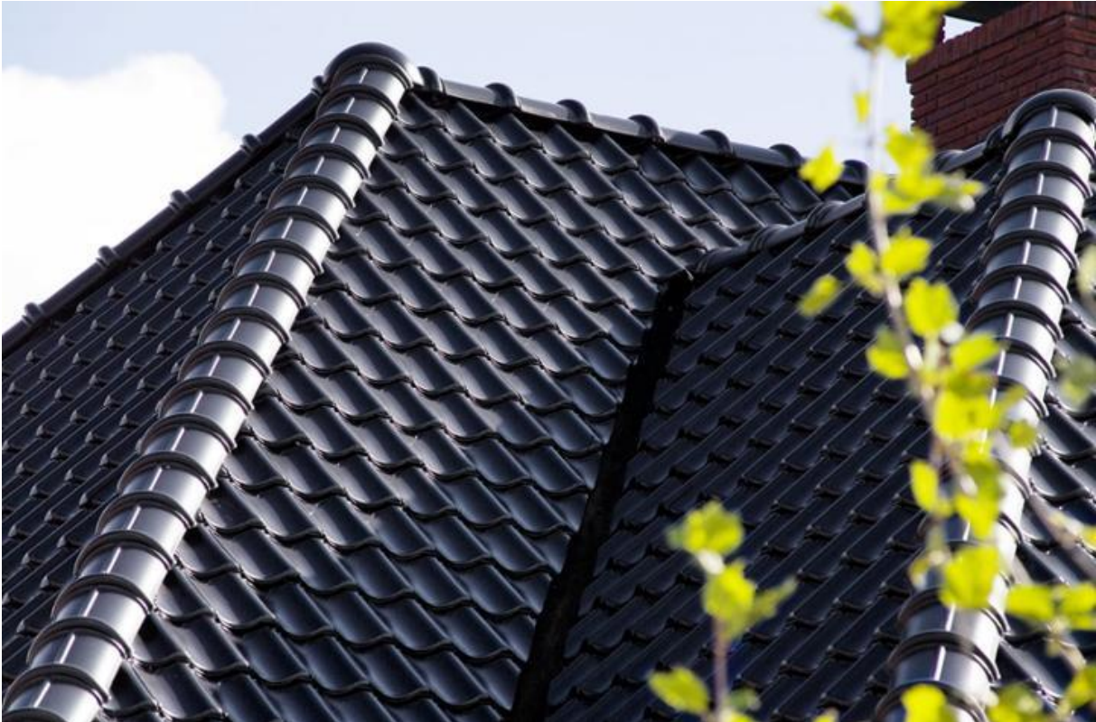
Afbeelding 46 Afdekking met rij hoekkepervorsten
