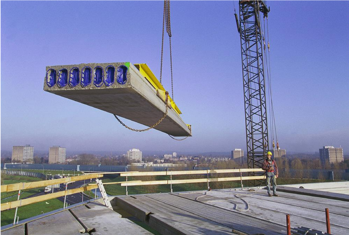
Afbeelding 14 Kanaalplaatvloer plaatsen
