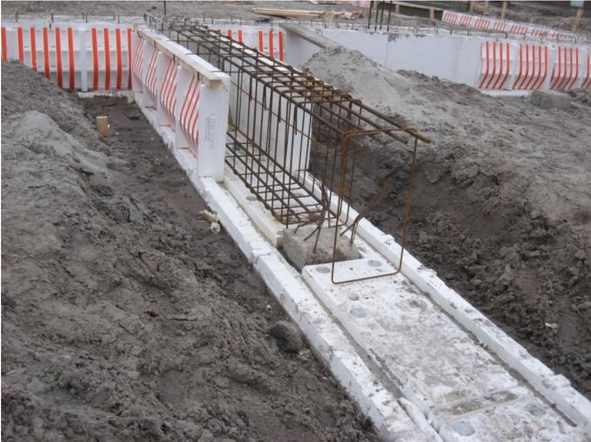
Afbeelding 13 Sparing in balkfundering
